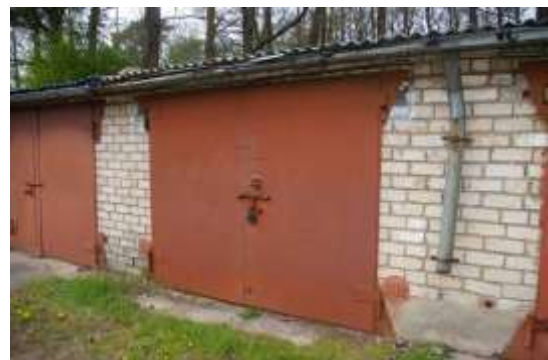
Būve ar kadastra apzīmējumu 1700 002 0135 004, garāža Nr.367
